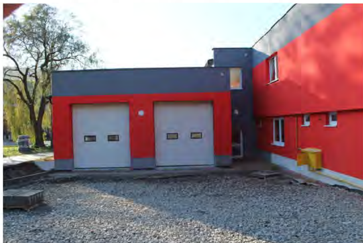
Rekonštrukcia hasičskej stanice
