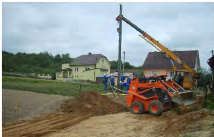
Výstavba na novej ulici: kanalizácia, elektrina
