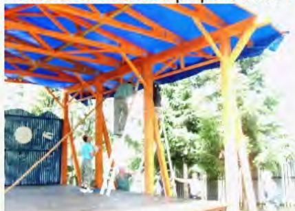
Zastrešenie a prestavba pódia, amfiteátra
