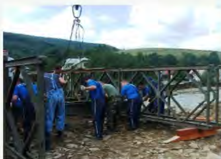
Výstavba mosta (Bayley Bridge)
